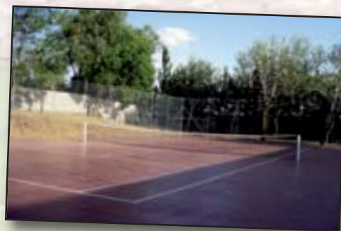
Obras. Pista de Tenis.
