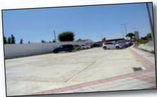
Obras. Acceso Polideportivo.
